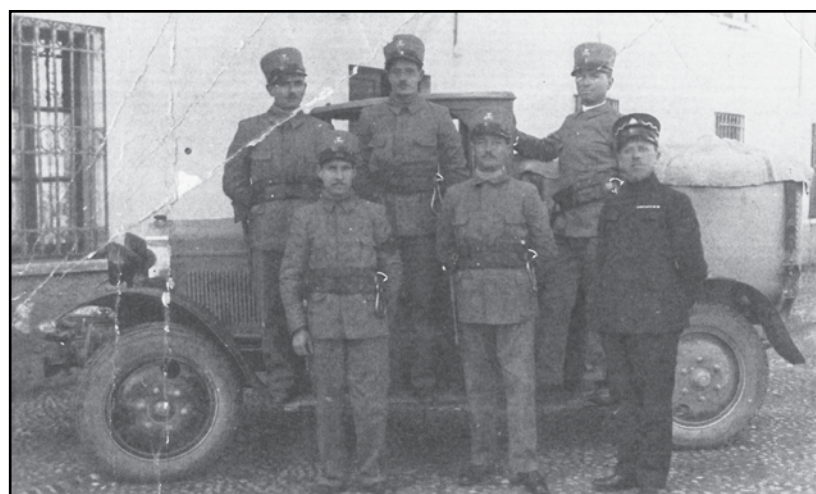
Vigili del Fuoco con automezzo.
